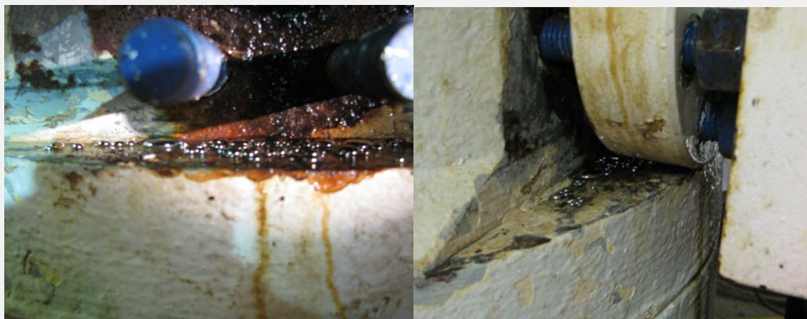
Abb. 9: Bild eines aufgeschraubten Ventils von der Plattform Ekofisk
